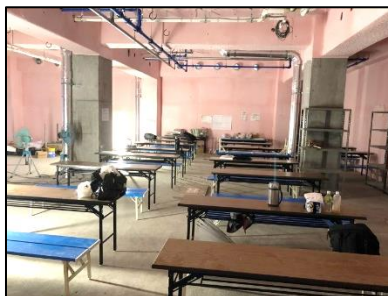
現場詰所の様子
