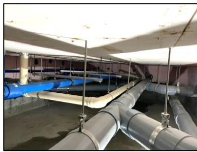
配管 施工状況
