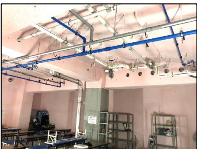
配管 施工状況
