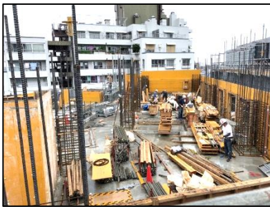
6階部分の建込み状況
