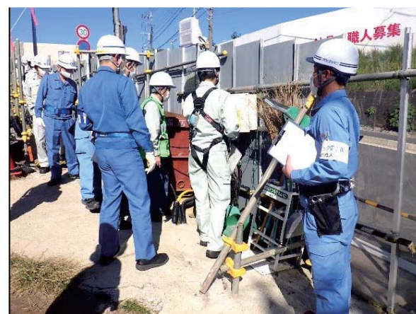
安全パトロール実施状況
