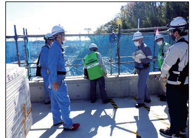
安全パトロール実施状況
